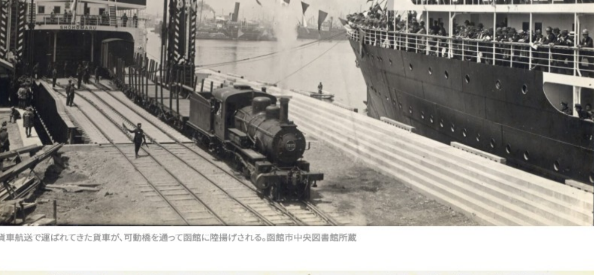
貨車航送で運ばれてきた貨車が、可動橋を通して函館に陸揚げされる。函館市中央図書館所蔵
