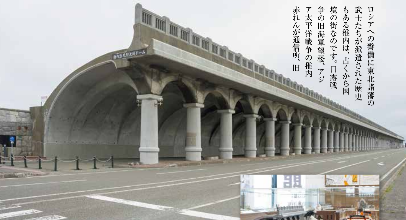
(上) 防波堤に激突する波しぶきから乗客を守る、底のついた構造の稚内港北防波堤ドーム。 稚内と樺太の大海を結ぶ稚泊航路で引き揚げた人々を迎えた。1936年(昭和11)竣工。 (右) 稚内市樺太記念館には北防波堤ドームと連絡船と列車の関係がわかるジオラマを展示。
