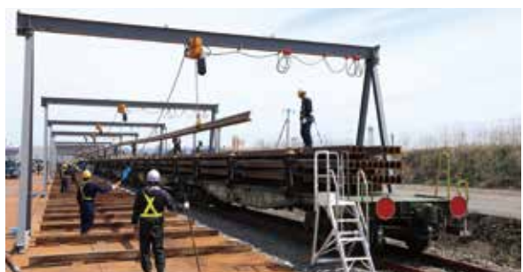
150mレールは、9台の門型クレーンで1本ずつ取り卸す(長万部町内)
