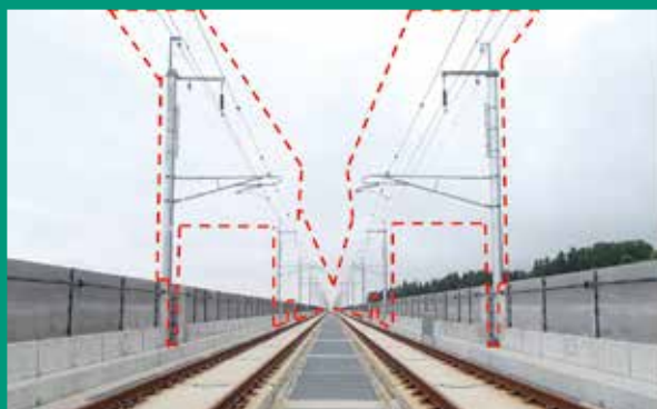
電車線工事の範囲(赤点線囲み部分)
