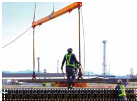
レールの一時仮置き場所での貯積作業の様子
