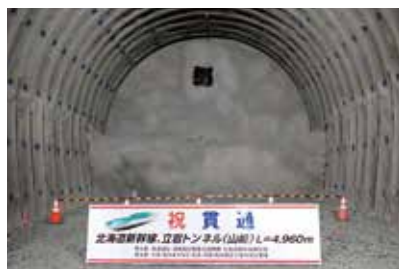
貫通した立岩トンネル(山崎)工区の様子
