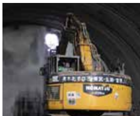
幌内トンネル貫通の様子
