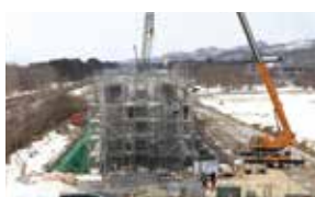
平里高架橋建設工事の様子
