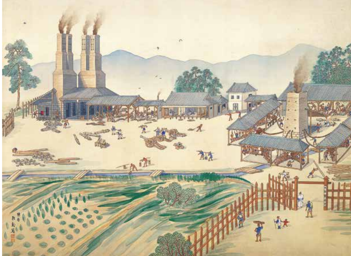
オランダの書物を頼りに、佐賀城下の築地（ついじ、現・佐賀市長瀬町）に完成した日本初の反射炉（左端）。1851年（嘉永4）には良好な溶鉄ができた。右端には日本在来のたたら製鉄も描かれている。1853年のペリー来航後、幕府からの鉄製大砲の注文を受け、新たに多布施（たふせ）反射炉が建造された。技術を独占しない方針で、箱館の諸術調所教授・武田斐三郎も見学した。直正、島その他、佐野常民、副島種臣、大木喬任、江藤新平、大隈重信、枝吉神陽の「佐賀8賢人」を輩出した佐賀は、近代日本の礎を築いた人材の宝庫でもある。「築地反射炉絵図（考証復元図）」（公財）鍋島報効会所蔵
