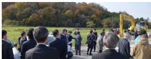
新八雲(仮称)駅建設予定地の様子
